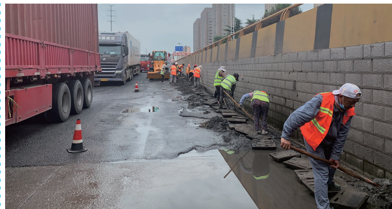
针对近期强降雨造成开发区新光路立交下穿路面积水严重情况,8月26日,华茂裕养护公司组织30多名职工突击清理立交下穿路面两侧排水沟道淤积,奋战4个小时,清淤20余立方,疏通排水沟道,保障过往车辆平安通行,提升港城文明形象。(陈大壹)
